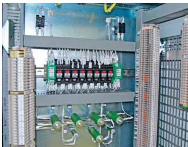
Установка блока фильтра оперативного питания для терминалов непосредственно на монтажной плате.
