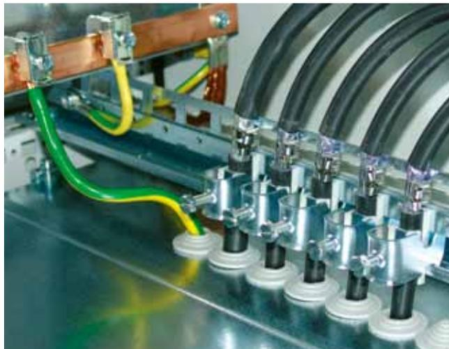
Заземление экранов внешних кабелей к экранной шине проводится сразу на входе в шкаф и заземляется с помощью кабельных хомутов. Экран и внешняя оболочка кабеля ведется без разрывов до места подсоединения к клеммам ряда зажимов, но там экран не заземляется.
