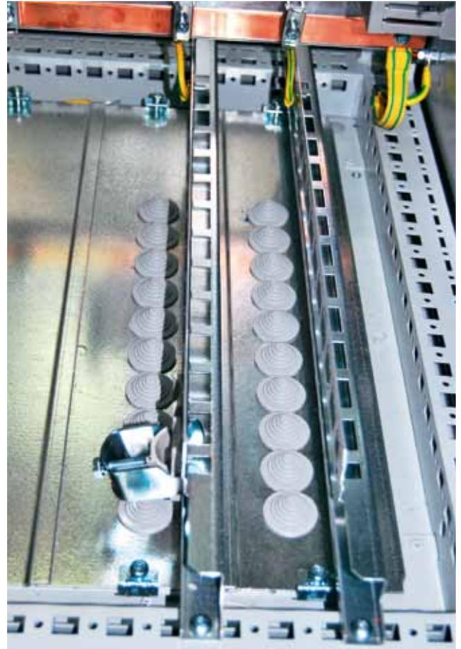
Подвод внешних кабелей предусмотрен сверху и снизу, через кабельные вводы, расположенные на крыше и в основании шкафа. Обеспечивается механическое крепление внешних кабелей и заземление экранов кабелей сверху или снизу непосредственно на вводе их в шкаф.
