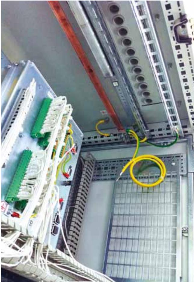
Основание шкафа с гермовводами и устройством для механического крепления и заземления экранов внешних кабелей.
