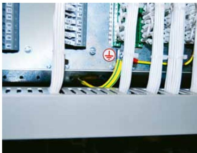
Установка терминалов на монтажной плите (вид сзади) с выполнением заземления плоским проводником.
