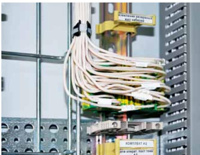
Заземление резервных жил внешних кабелей.
