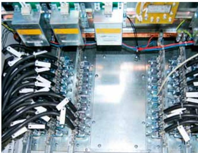
Ввод кабеля в основание шкафа. Кабели механически закреплены к кабельным шинам с помощью специальных зажимов. Экран кабеля с большой площадью контакта соединен с кабельной шиной металлическими хомутами.
