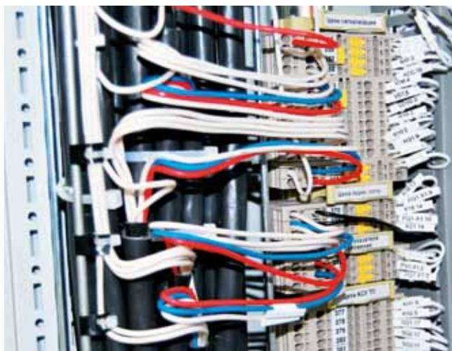
Подключение внешнего кабеля к клеммным зажимам.
